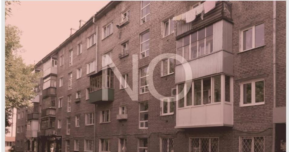
Рис. 4.3.1. Пример недопустимого устройства балконов на фасаде здания
