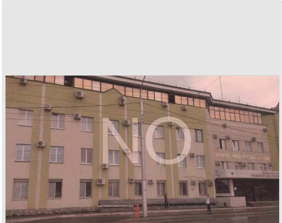
Рис. 4.4.1. Применение недопустимого способа крепления наружных блоков кондиционеров
