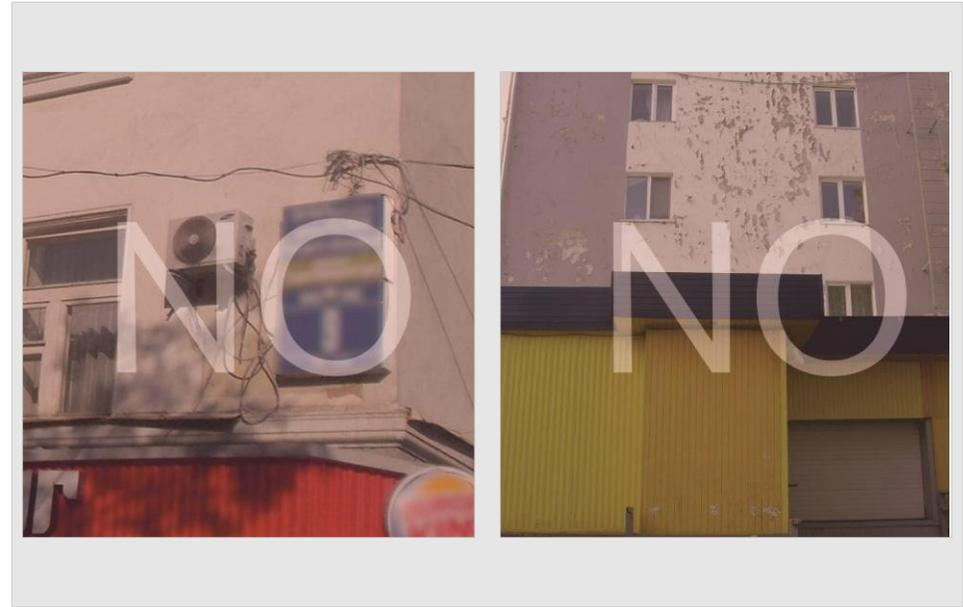
Рис. 3.11 Запасы кабеля, повреждённая отделка, профнастил
