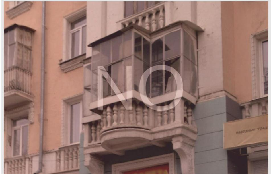
Рис. 4.3.2. Пример недопустимого изменения балкона, не соответствующего архитектурной стилистике
