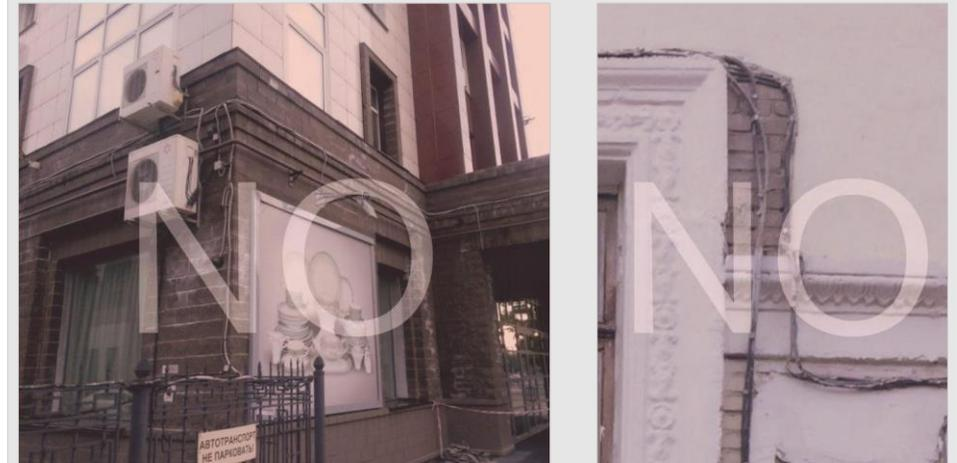
Рис. 3.13 Прокладка кабеля открытым способом
